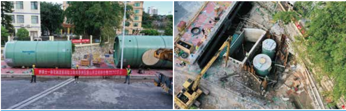
珠海香洲轴流泵站 • 双筒并联 雨污分流 • 单筒13万吨/天
